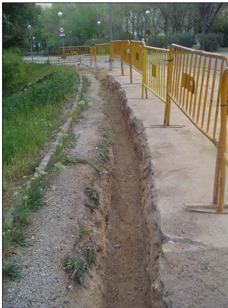
Il·lustració 2: Vista del tram final de la rasa per la instal·lació d'un cable telefònic.
